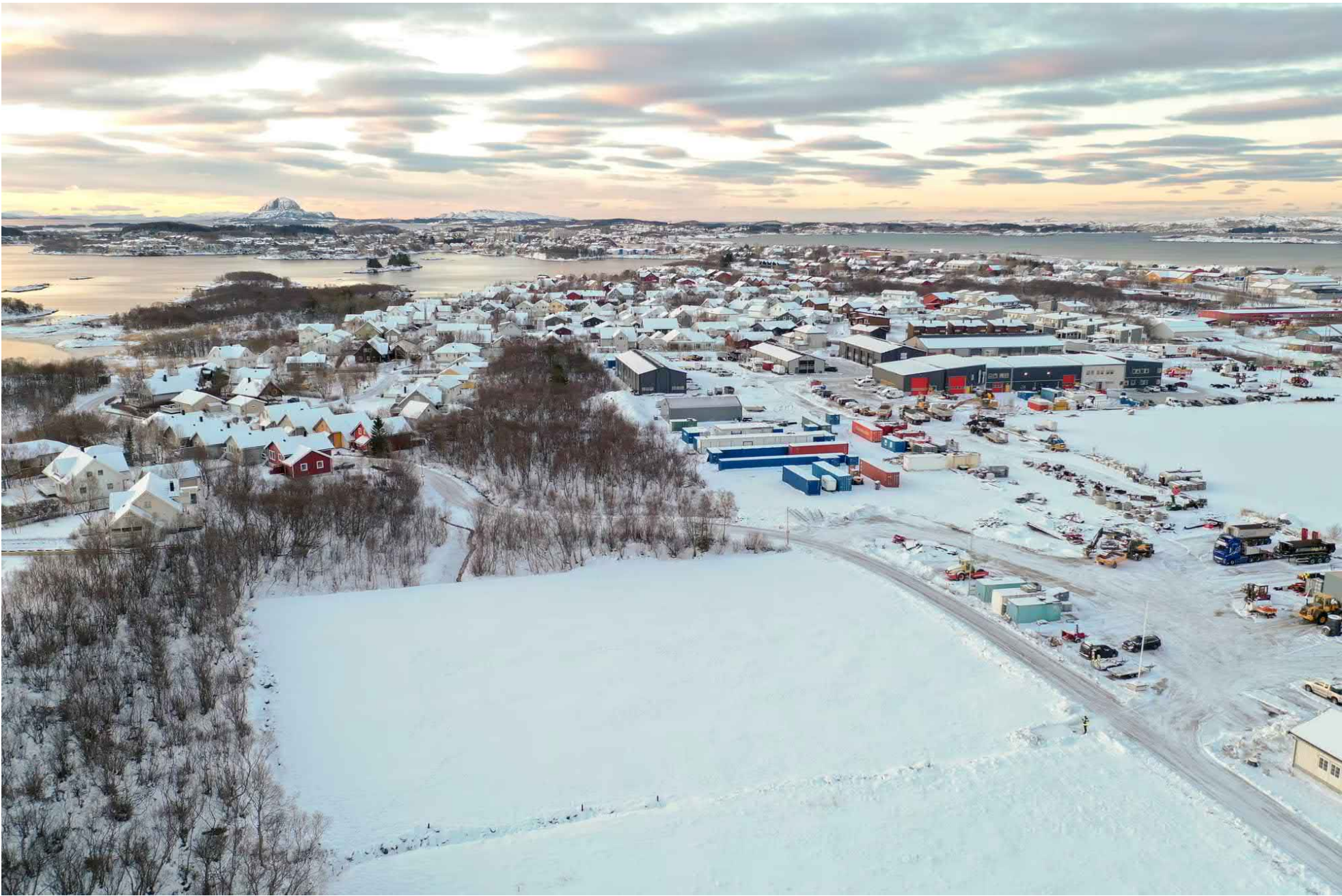
På denne tomten i Salhusmarka skal Lagerseksjoner Nord-Norge etablere to store lagerbygg. FOTO: LAGERSEKSJONER AS
