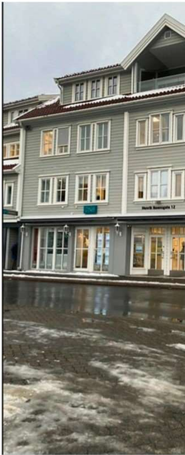
HER STARTET DET: Sverre Engebretsen foran bygget i Ibsengate i Grimstad sentrum hvor suksesshistorien startet, og fortsatt har hovedkvarter. I de to etasjene over DrB driver Engebretsen kontorleieselskap med om lag 15 bedrifter innenfor bygg, eiendom og finans. FOTO: PRIVAT
