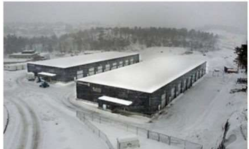
MOLAND PARK: To bygg med i alt 32 lagerseksjoner er nå ferdigstilt i Moland Park, næringsparken til Asbjørn Sandås rett øst for Arendal by og rett syd for den nye E18. FOTO: LAGERSEKSJONER AS
