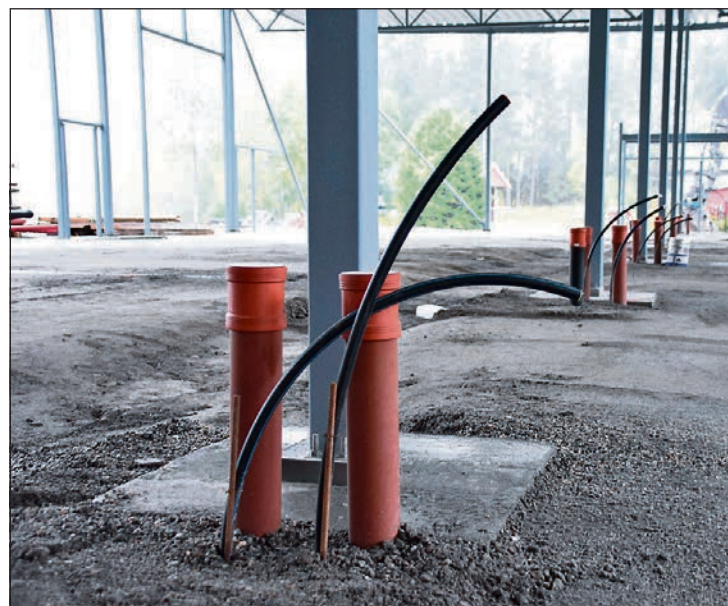
PÅ VEI OPP: Av fasiliteter er det mulig å koble seg på vann og videre er seksjonene isolerte og frostfrie og har god takhøyde.
